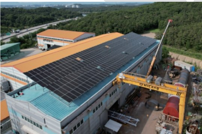
제3 공장 태양광 구조물 및 부속제작
