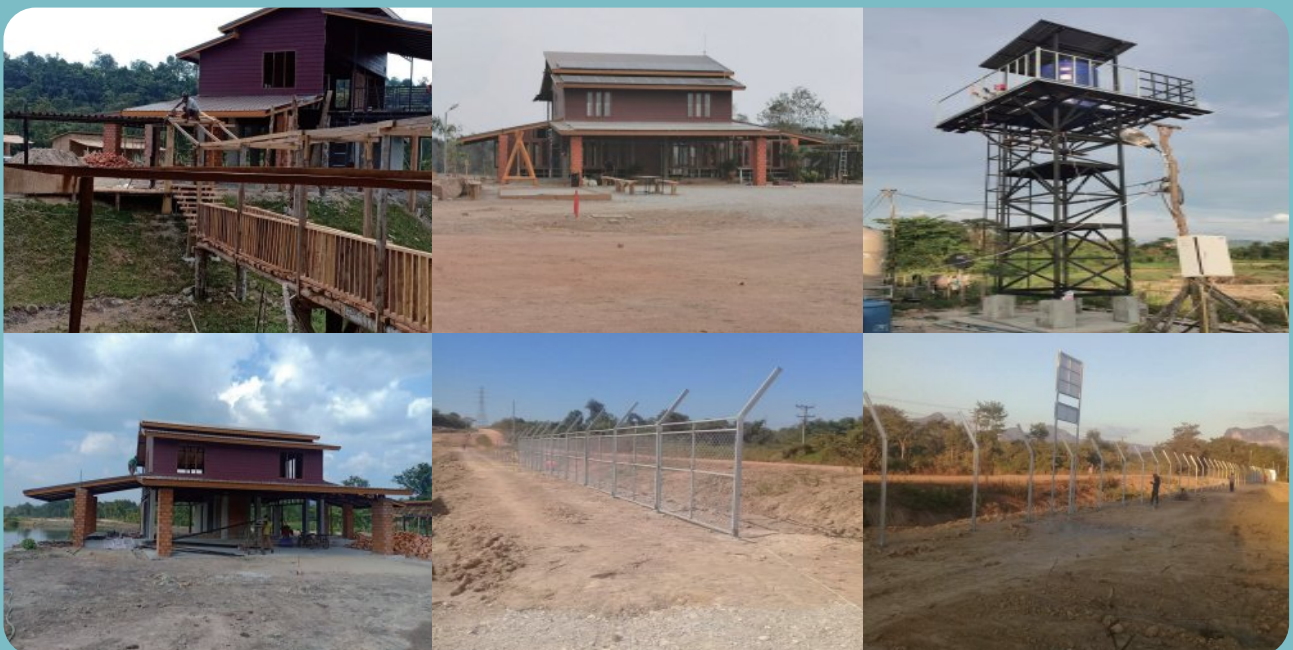
라오스 25만평 240Mw급 (단계별 공사중)
