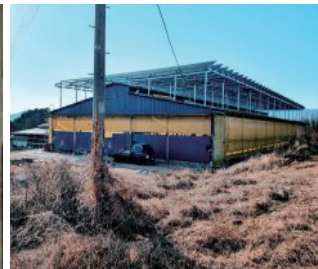
거창 축사 지붕(200kW)
