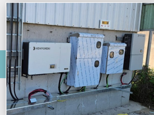
9. 인버터 및 수배전 설치
