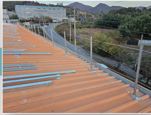
2. 안전난간대 설치
