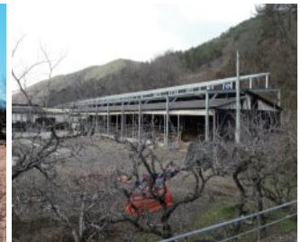
밀양 축사 스테이지붕 보강 (100kW)
