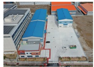
울주군 공장옥상지붕 2차공사 (500kW)
